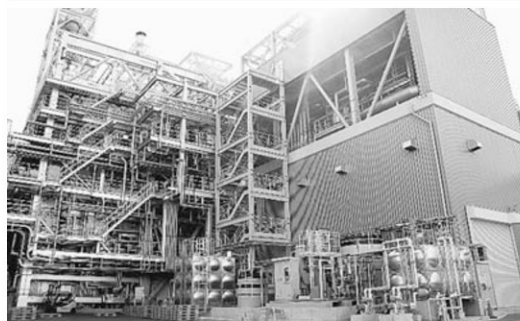
産業廃棄物焼却時の廃熱を活用し、家庭約5千世帯分の電力を供給する3号焼却炉(京都市伏見区・京都環境保全公社)
